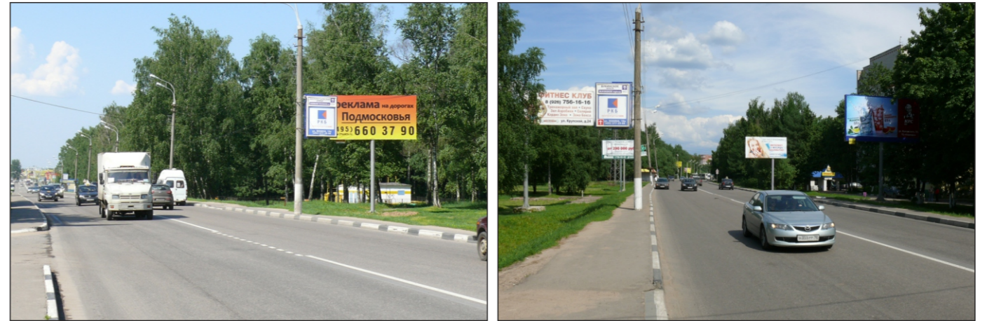
Конструкция 112 а/д. Лобня - а/п. Шереметьево, 2 км + 124 м, справа
