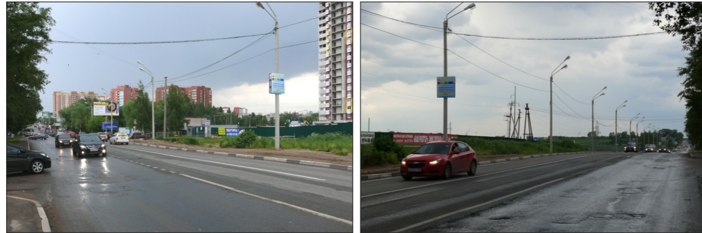
Конструкция 14 а/д. Хлебниково-Рогачёво, 5 км + 415 м, слева
