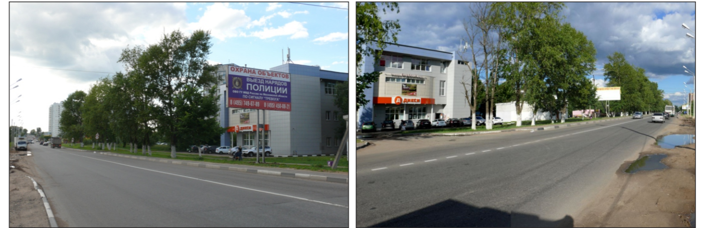
Конструкция 15 а/д. Хлебниково-Рогачёво, 5 км + 514 м, справа
