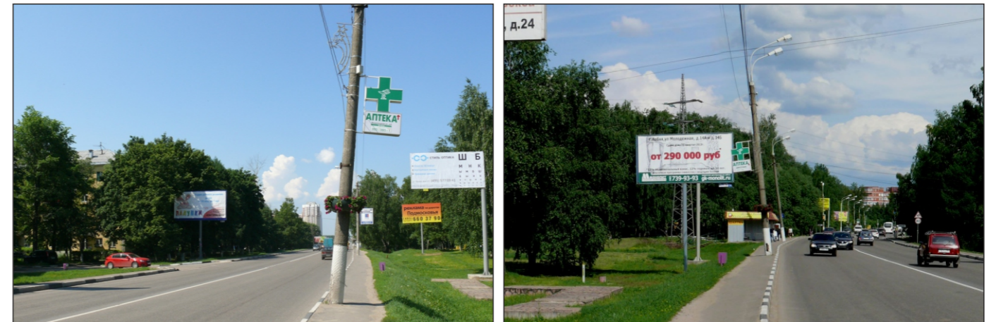
Конструкция 108 а/д. Лобня - а/п. Шереметьево, 2 км + 073 м, справа
