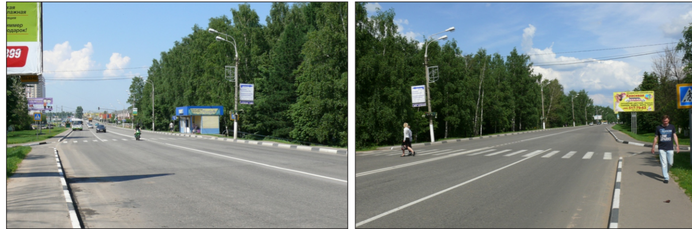
Конструкция 115 а/д. Лобня - а/п. Шереметьево, 2 км +370 м, справа
